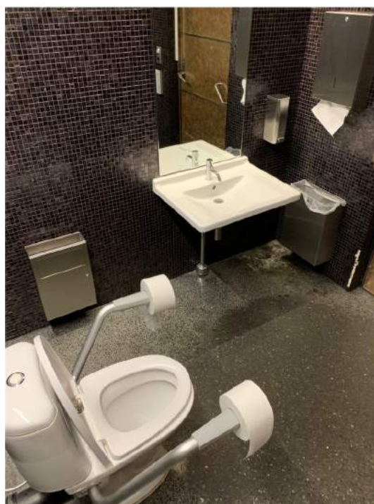
Fot. 6. Wyposażenie toalety powinno być skontrastowane z tłem oraz uzupełnione o odpowiednie uchwyty i pochwyty. I. Benek, 2020.
