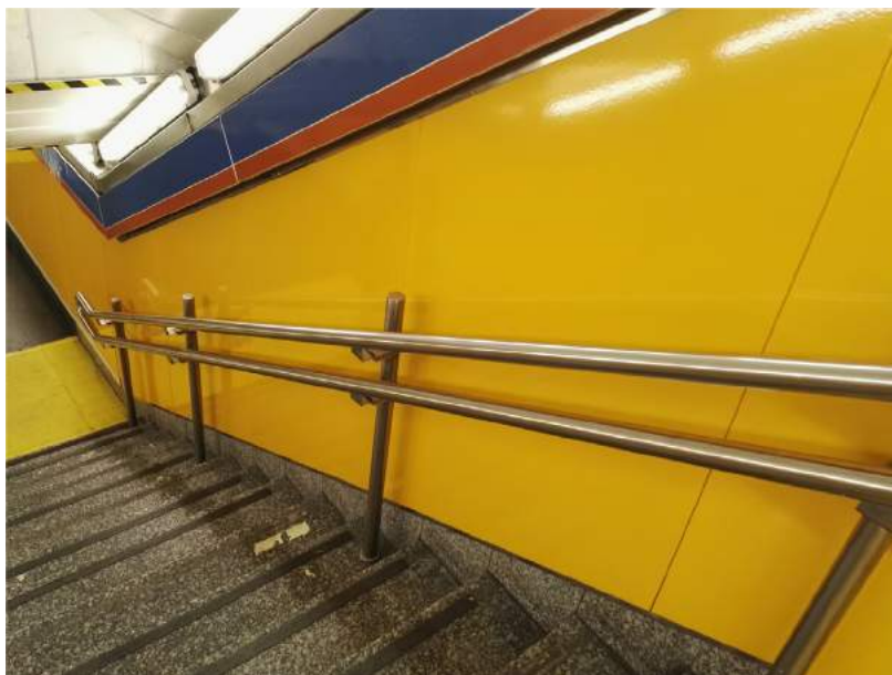
Fot. 3. Balustrada z pochwytaami na dwóch wysokościach jest elementem wspierającym bezpieczeństwo i samodzielność osób starszych. A. Labus, 2017.
